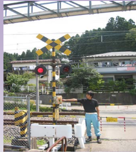
踏切用非常ボタン
