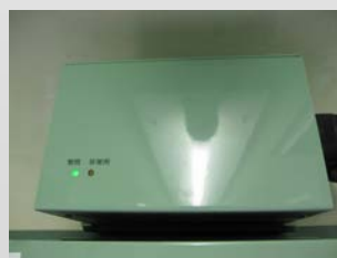
防護無線非常電源切換継電器
