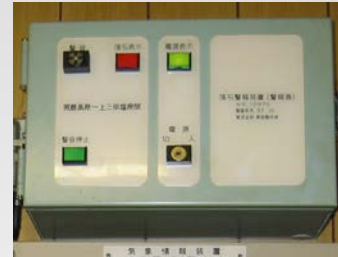
落石検知表示装置
