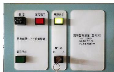
落石検知表示装置
