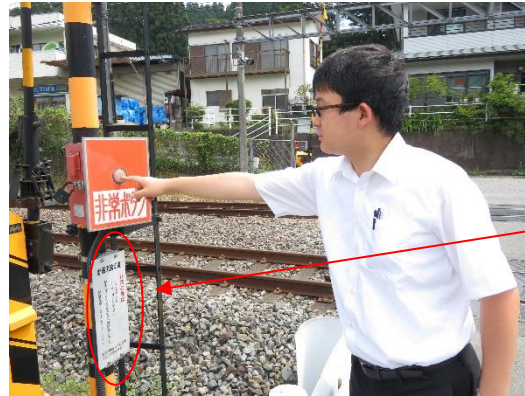
踏切道へ設置
