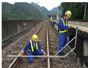
駅ホームの離れ及び高さ測定
