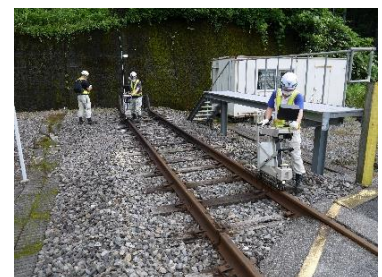
手押し式の超音波探傷検査
