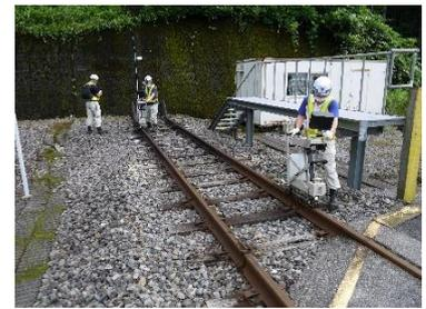
手押し式の超音波探傷検査
