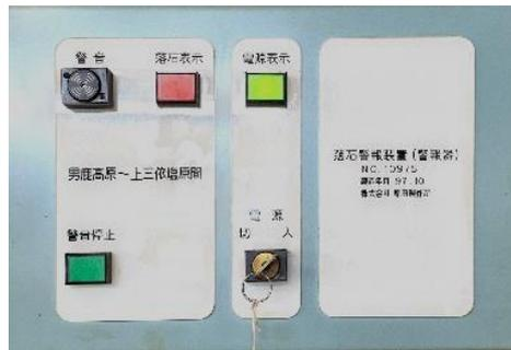
落石検知表示装置
