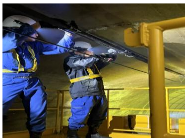
トンネル内頂部の補修・修繕箇所調査（葛老山トンネル他）
