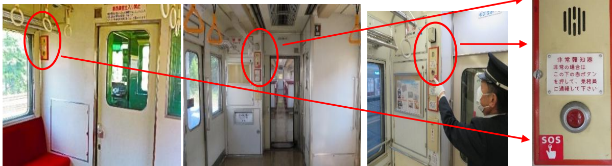
車内前方・後方に設置されている非常報知器
