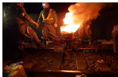
夜間作業（レール溶接）
