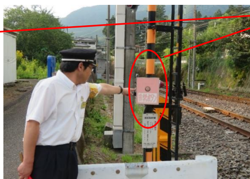
踏切道へ設置
