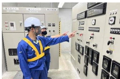
変電設備の点検
