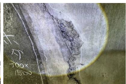
トンネル内頂部の補修・修繕箇所調査（葛老山トンネル他）
