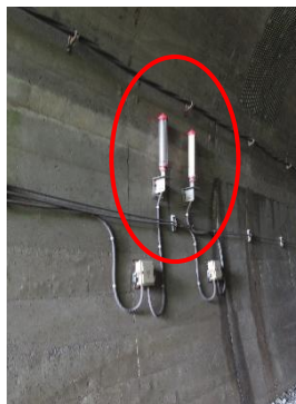
列車への落石検知表示装置
