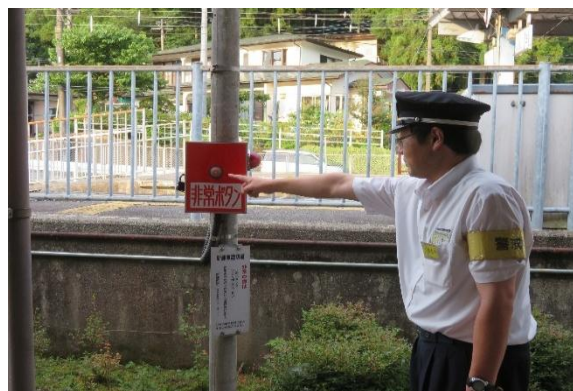
非常押しボタン
