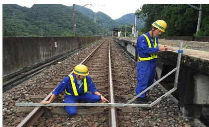
駅ホームの離れ及び高さ測定
