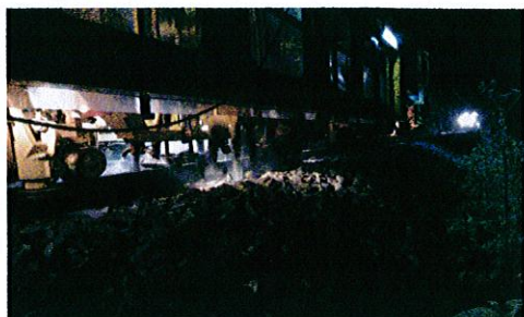
(マルチプルタイタンパー作業の様子)
