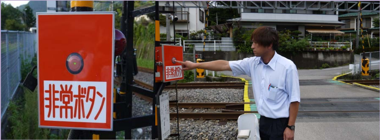
踏切用非常ボタン
