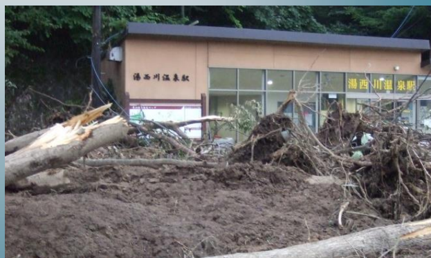
湯西川温泉駅前 駅裏斜面の土砂崩れ
