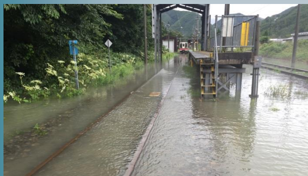
会津高原尾瀬口駅構内 駅構内の冠水
