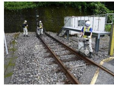
手押し式の超音波探傷検査
