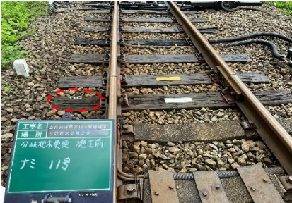
施工前（枕木更换箇所（ ））
