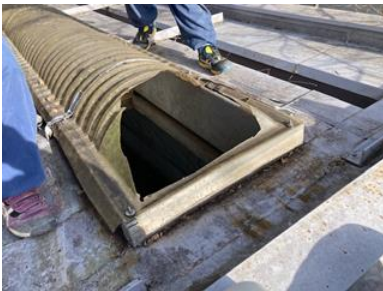
改修前（改修箇所）
