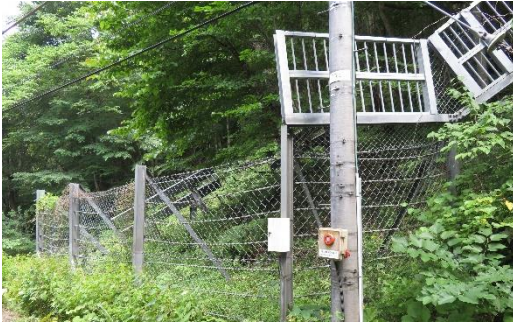
現地の落石検知装置
