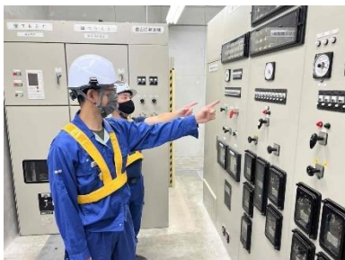
変電設備の点検
