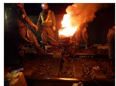
夜間作業（レール溶接）
