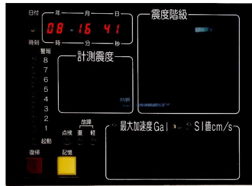
地震計震度表示装置
